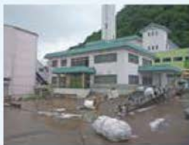
浸水したクリーンセンターの全景
