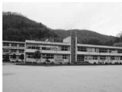
建て替えられる成羽中学校校舎
