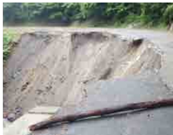
崩落した道路
