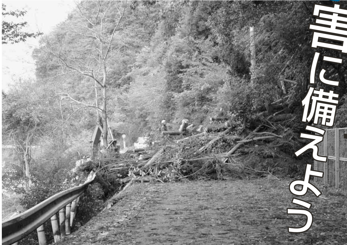
山林の土砂災害により、遮断された道路（平成16年10月・備中町平川井川地区）
