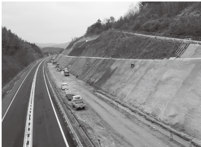
岡山自動車道付加車線設置工事（高梁市有漢町地内）
