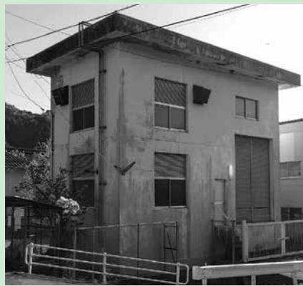
島木川内水排除設備
