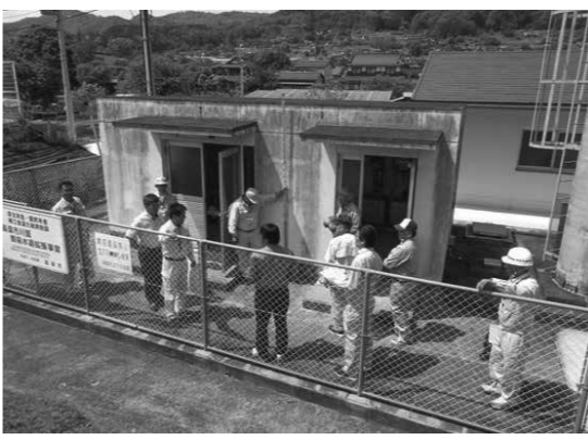
川面巨瀬簡易水道川面第2水源池
