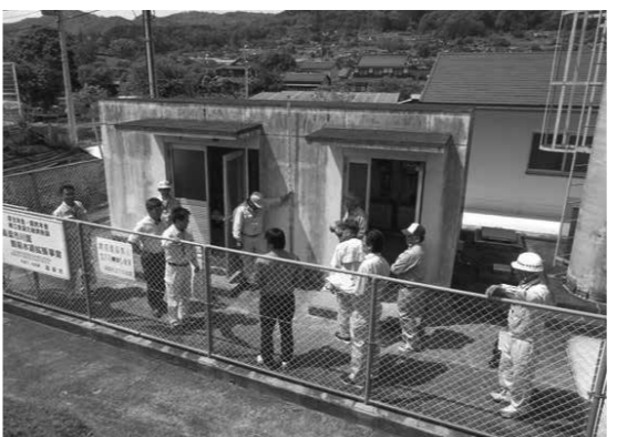
川面巨瀬簡易水道川面第2水源池
