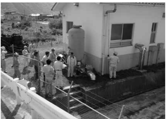
阿部地域にある上水道第3水源池
