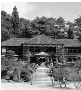
▲修復工事前の吹屋小学校
