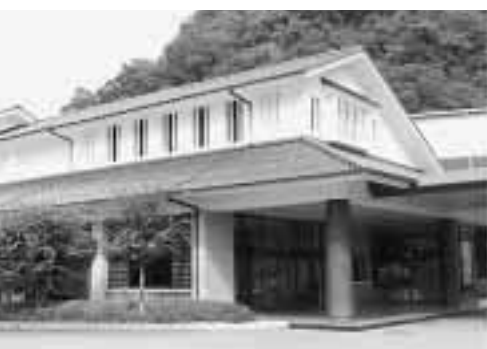
火葬炉が増改築される斎場
