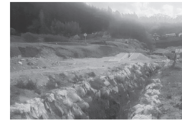
高倉町肉谷地区の復旧工事
