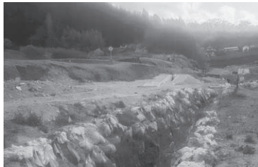
高倉町肉谷地区の復旧工事
