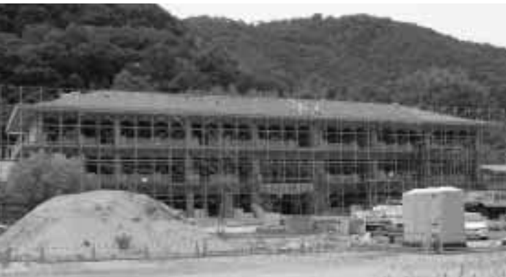
建設中の成羽中学校
