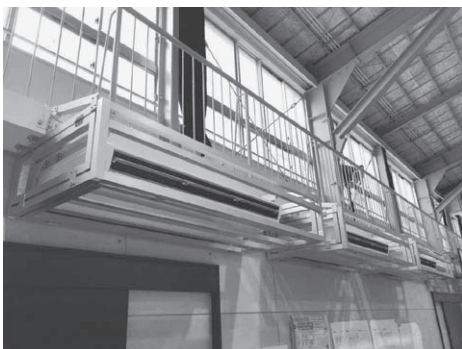
横浜市立日吉南小学校の体育館 (体育館空調モデル設置校)
