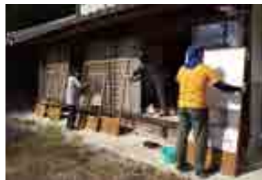
空き家の障子を張り替え
