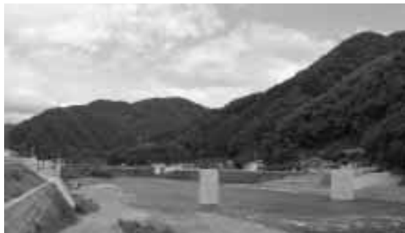
橋脚ができた阿部神崎橋（市道玉川落合線）
