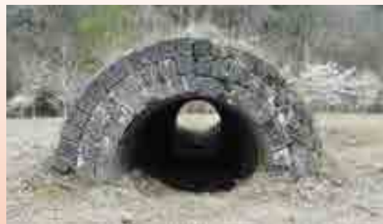
トロッキ用のトンネル跡
