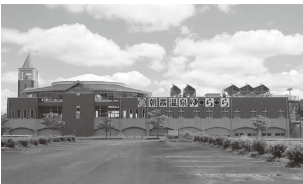
旧高梁市健康増進施設「朝霧温泉ゆ・ら・ら」
