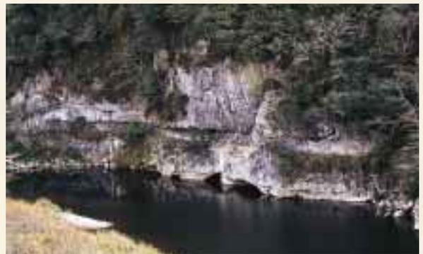
成羽川沿いの岩肌に残る専用軌道の跡。原料や製品などの運搬は明治32年に全通した東城往來を馬車輸送に頼っていたが、輸送量の確保などを目的に明治37年専用軌道の敷設に着手。広島県深安郡の水田市太郎が工事を請け負った。成羽一田原間の道幅は約1.5m、延長約16km。高さ奥行きとも2m掘削した難工事箇所もあった。
