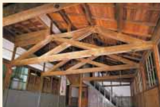
三間廊下天井の小屋組
