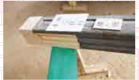
傷んだ柱の補修
