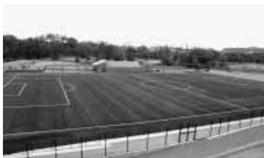
完成に向け工事が進む神原スポーツ公園多目的グラウンド
