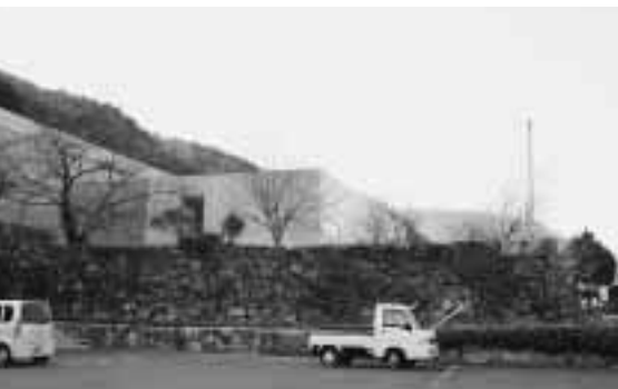
伐採後の石垣
