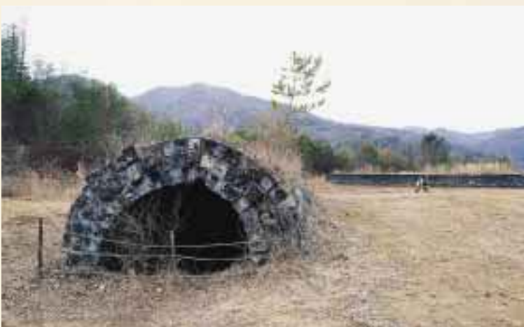
トンネルのようなアーチ構造の暗渠。拱渠。鉄道敷設工事などで築堤を造ると地域が分断されるため、カルベルトを設置してその上に土塁を築き、道路や水路を通す。わが国初の鉄道トンネルとなった石屋川トンネルなど阪神間の3橋梁も、カルベルトを用いた開削工法であった。
