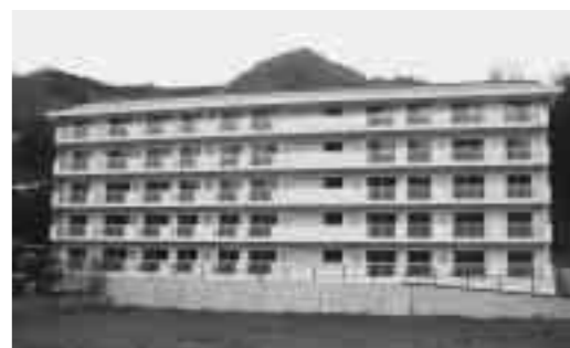
完成した上谷第2住宅
