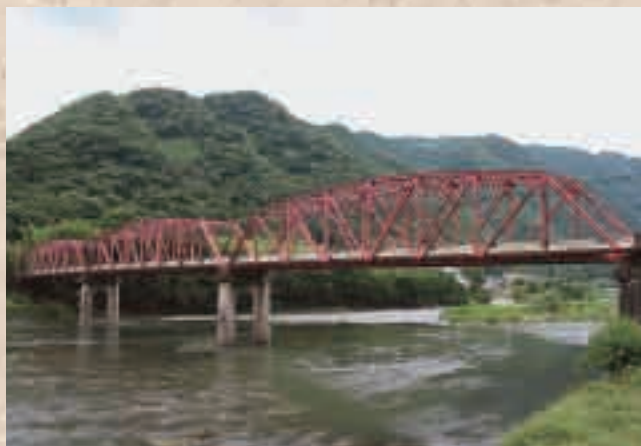
長い支間長のワレントラスが3つ連なる美しい玉川橋。洪水の時も流木などが引っ掛りにくい橋脚、流面と通行路の間に構造物を持たない下路式は室戸台風復興橋梁ならではの特長。
