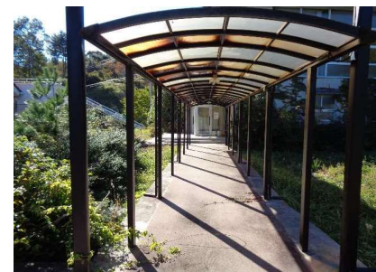
渡り廊下（校舎～屋内運動場）
