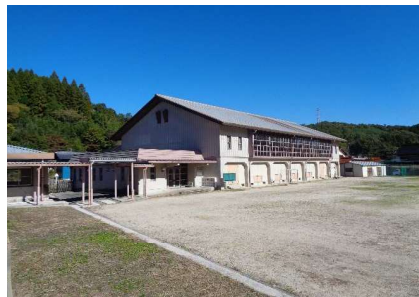
外観（屋内運動場）
