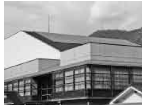
総合文化会館の傾斜屋根に設置した太陽光パネル
