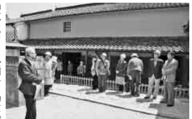
本柄蔵の展示室など整備し、今春、全面公開が始まった国指定重要文化財・旧片山家住宅
