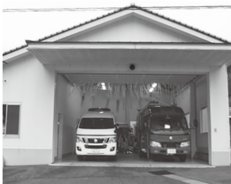
▲消防署西分駐署（備中町地内）
