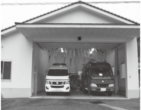
▲消防署西分駐署（備中町地内）
