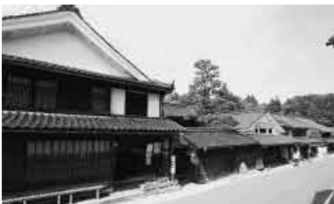
吹屋の伝統的建造物
