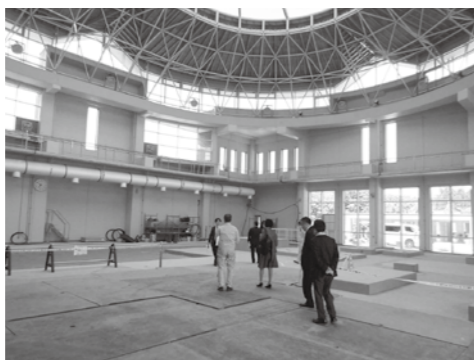
旧「ゆ・ら・ら」跡地に建設中の木質バイオマス発電所
