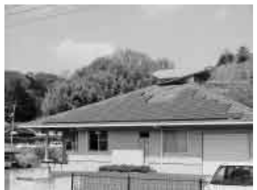
太陽光パネルを設置した建物
