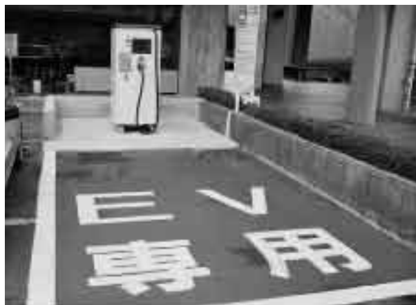
EV急速充電器
