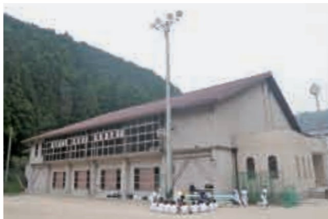
22年度に耐震補強工事を行った富家小学校体育館
