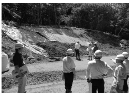
農道高岩線復旧工事現場
