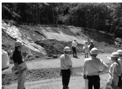
農道高岩線復旧工事現場
