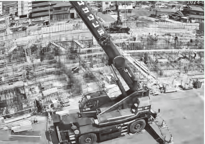
建設中の 高梁認定こども園（仮称）
