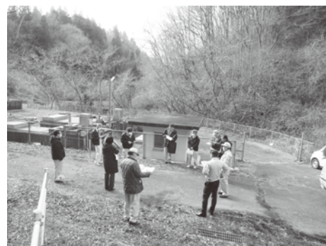
吹屋簡易水道浄水場
