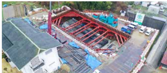
建設中の落合雨水ポンプ場
