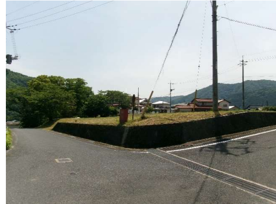
北側市道、西側市道
