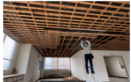
▲天井の解体作業風景。 失敗も含めてDIYの醍醐味と言い聞かせる。
