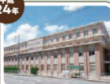
成羽病院本館棟完成
