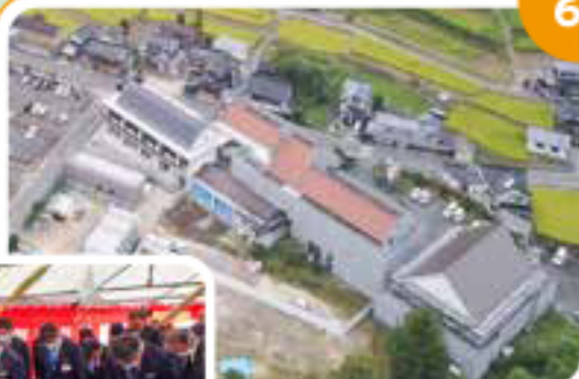
高梁市立有漢学園、 高梁こども園、 新消防庁舎を建設中
