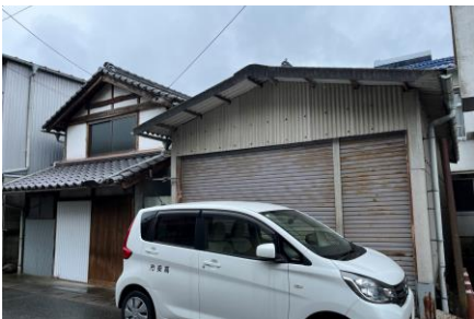
(倉庫・ガレージ)
