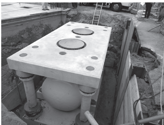
工期短縮のために 埋め込まれた地下タンク
