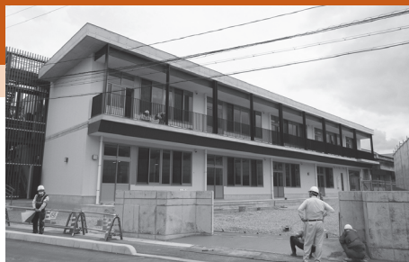
高梁市立有漢学園 開校に向けて工事が進行中
