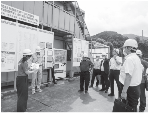
▲有漢学園の建設現場を視察
