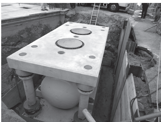
工期短縮のために 埋め込まれた地下タンク
