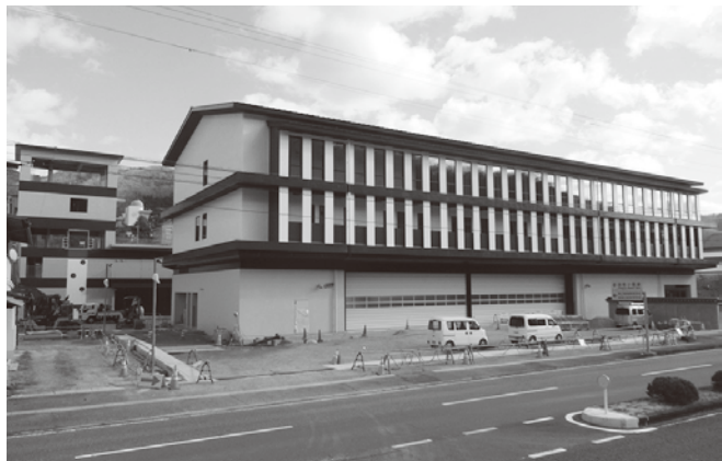
▲完成間近の新消防庁舎
