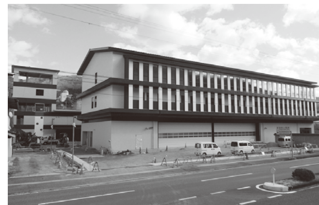
▲完成間近の新消防庁舎
