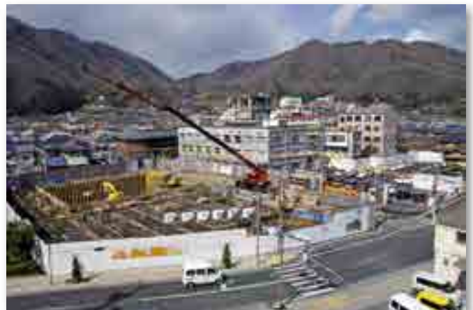
▲ 工事中の様子 (平成26年3月6日撮影)
