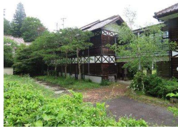
外観（西側 宿泊棟）
