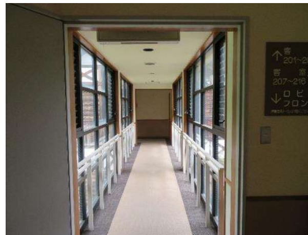
渡り廊下（本館棟2階→宿泊棟2階）
